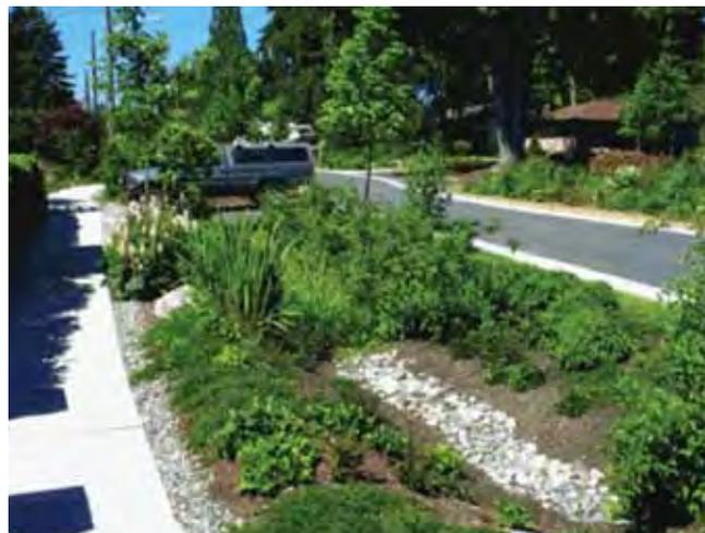
**Figure 3.3** Exemple d'aménagement d'une rue résidentielle avec biofiltration (Ville de Seattle, Washington).
