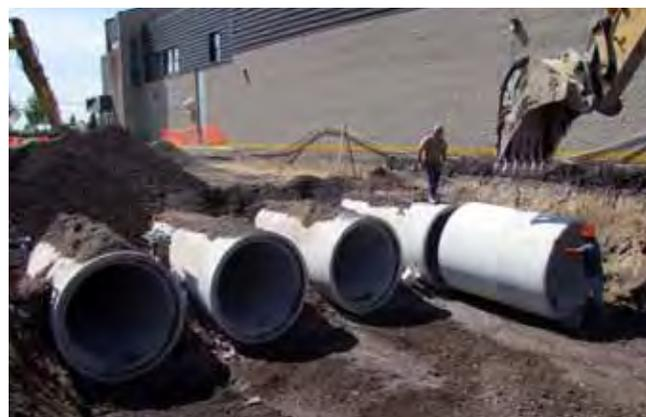
Figure 5.12 Exemples de conduites surdimensionnées pour le stockage sous un stationnement.
