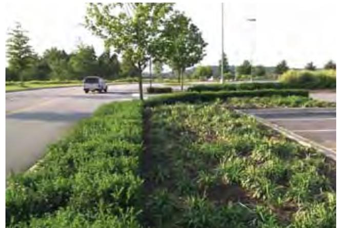
Figure 4.16 Zones de traitement pour un stationnement.
