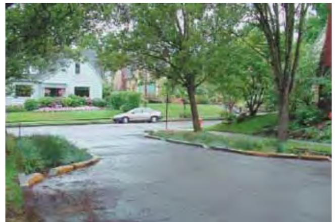
Figure 4.18 Exemple d'application d'éléments de contrôle de la circulation avec des zones pour le contrôle à la source.
