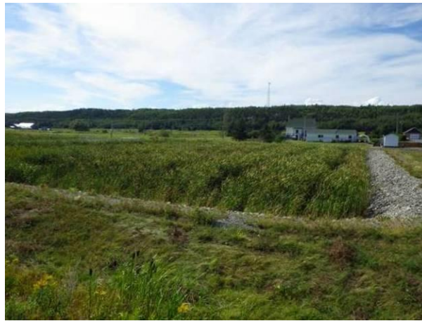
Figure 25: Marais filtrant de la municipalité de Saint-Simon
