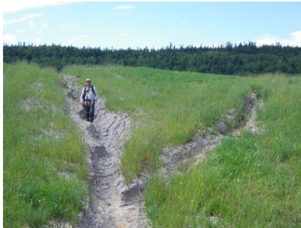
Figure 29: Érosion à la confluence de 2 fossés
