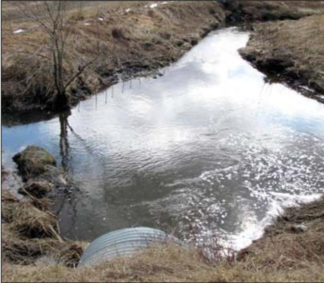
Photo 8 : Élargissement du lit d'un cours d'eau en aval d'un ponceau
