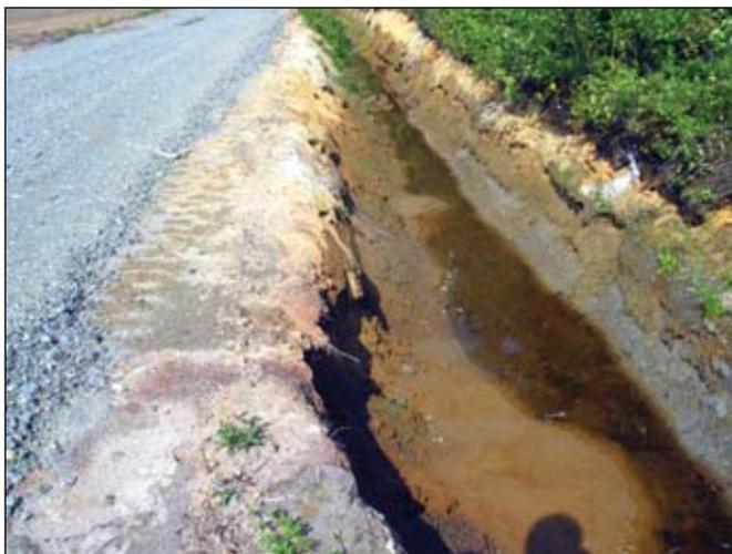
Photo 3 : Phénomène de boulangerie suite au creusage d'un cours dans un sol avec une nappe élevée
