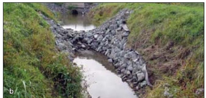
Photos 7 (a et b) : Seuils dissipateurs d'énergie
