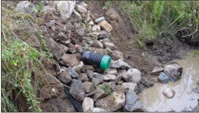
Photo 13 : Protection contre l'érosion à la sortie d'un drain
