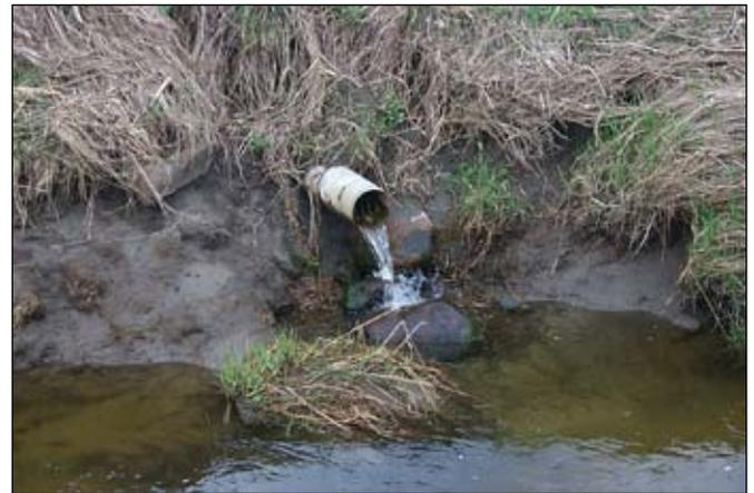
Photo 12 : Érosion à la sortie d'un drain
