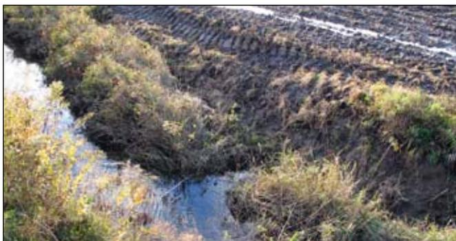
Photo 17 : Glissement suite à une charge excessive
