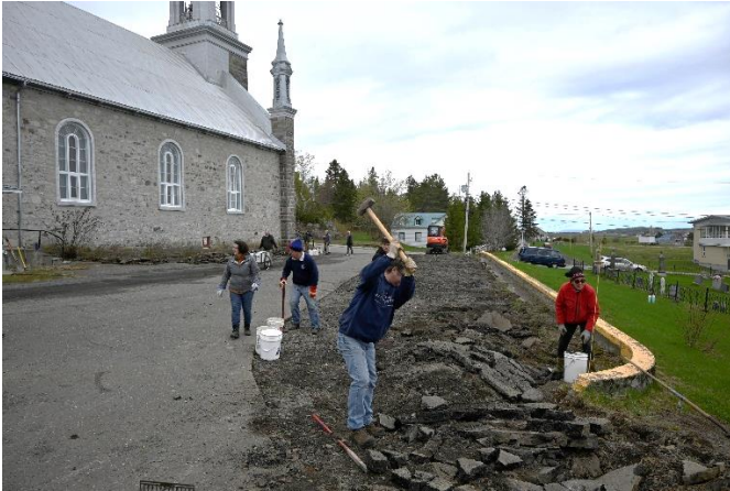
Photos des bénévoles qui retirent les morceaux d'asphalte à la main.
